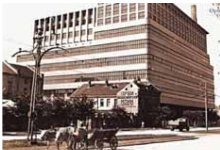
D. Braşovan - Zgrada BIGZ-a
